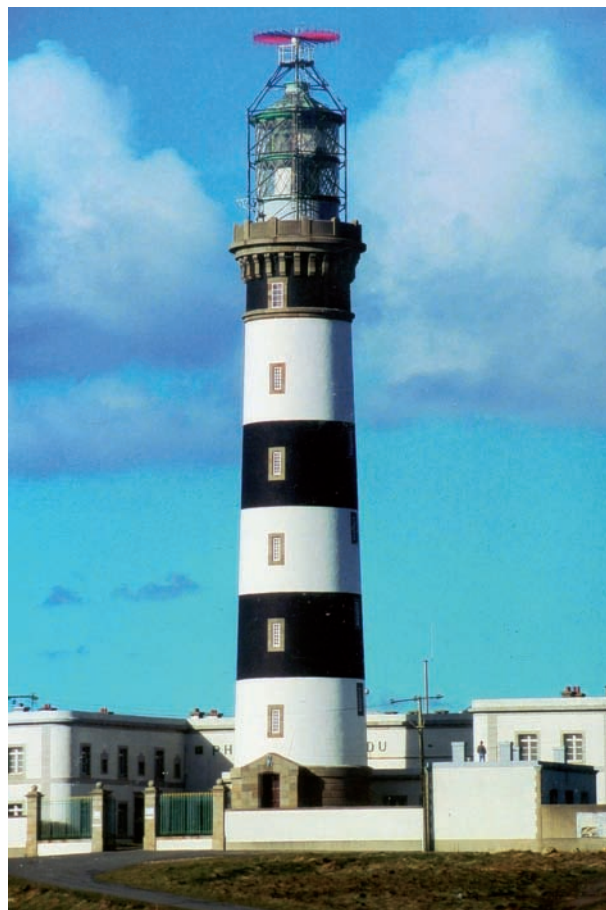
Station de contrôle du phare du Créac'h
